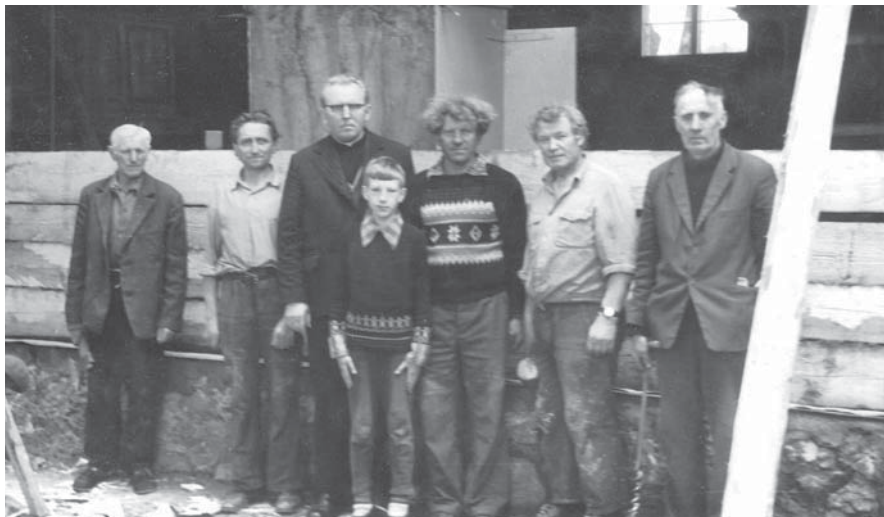
Remontuojant Viduklės bažnyčią, 1977 m.
